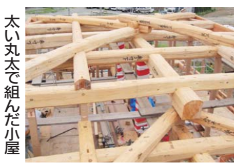
太い丸太で組んだ小屋組みは、木と木がしっかりと組み合わり地震に強い
